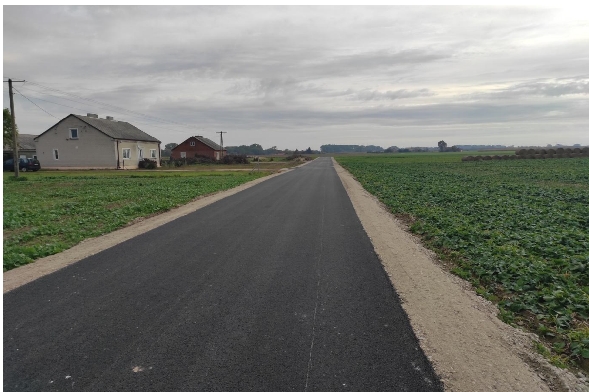
Droga gminna po realizacji
