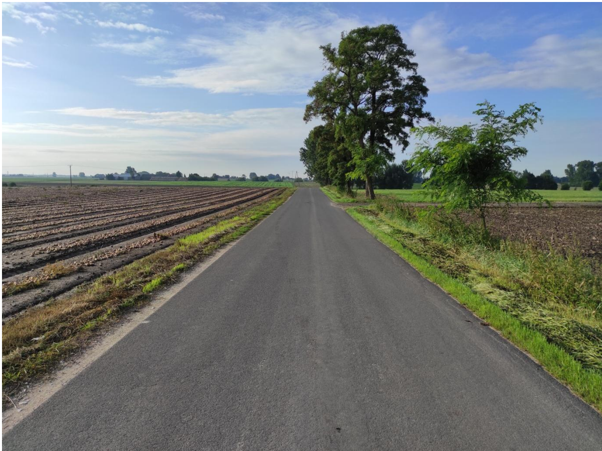
Droga gminna 190663C Sułkowo – Siemnowek przed realizacją
