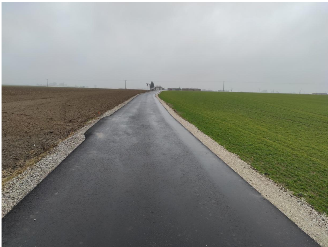
Droga po realizacji
