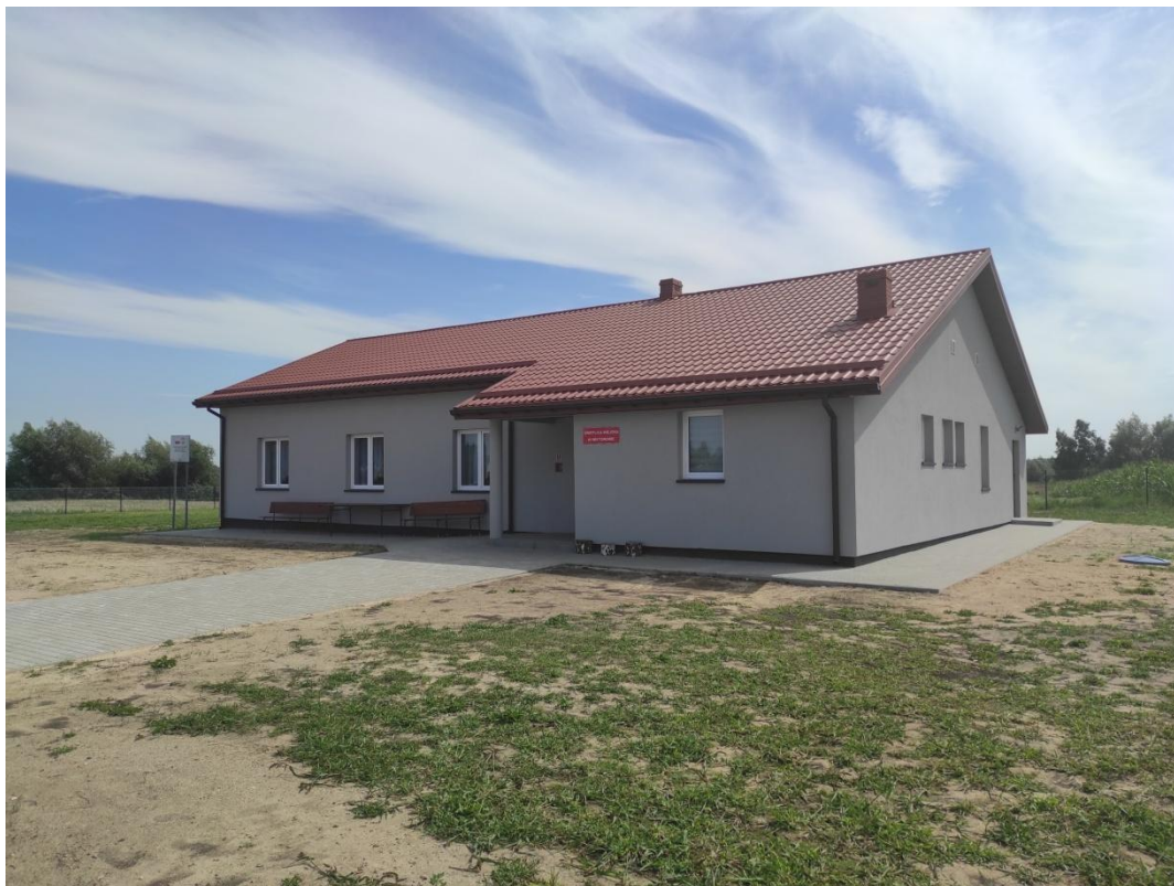
Budynek po realizacji
