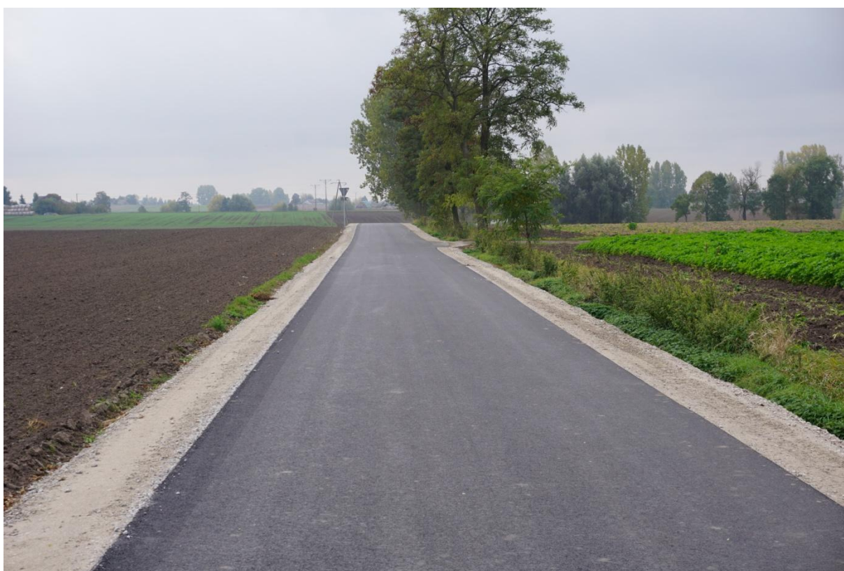
Droga gminna 190663C Sułkowo – Siemnowek po realizacji
