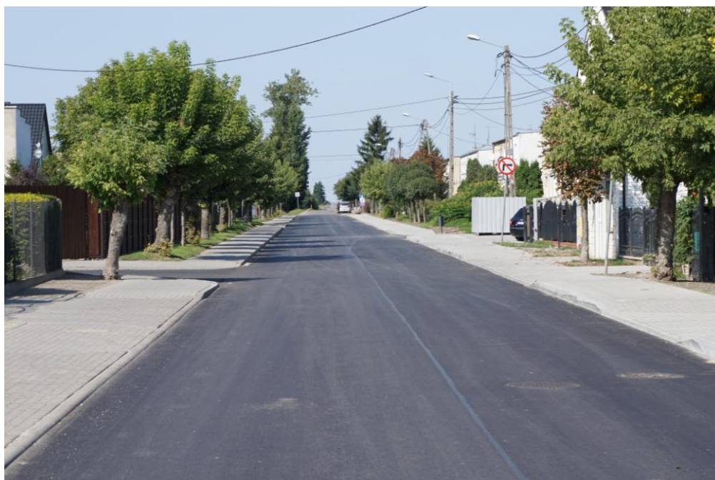
ul. Szkolna po realizacji
