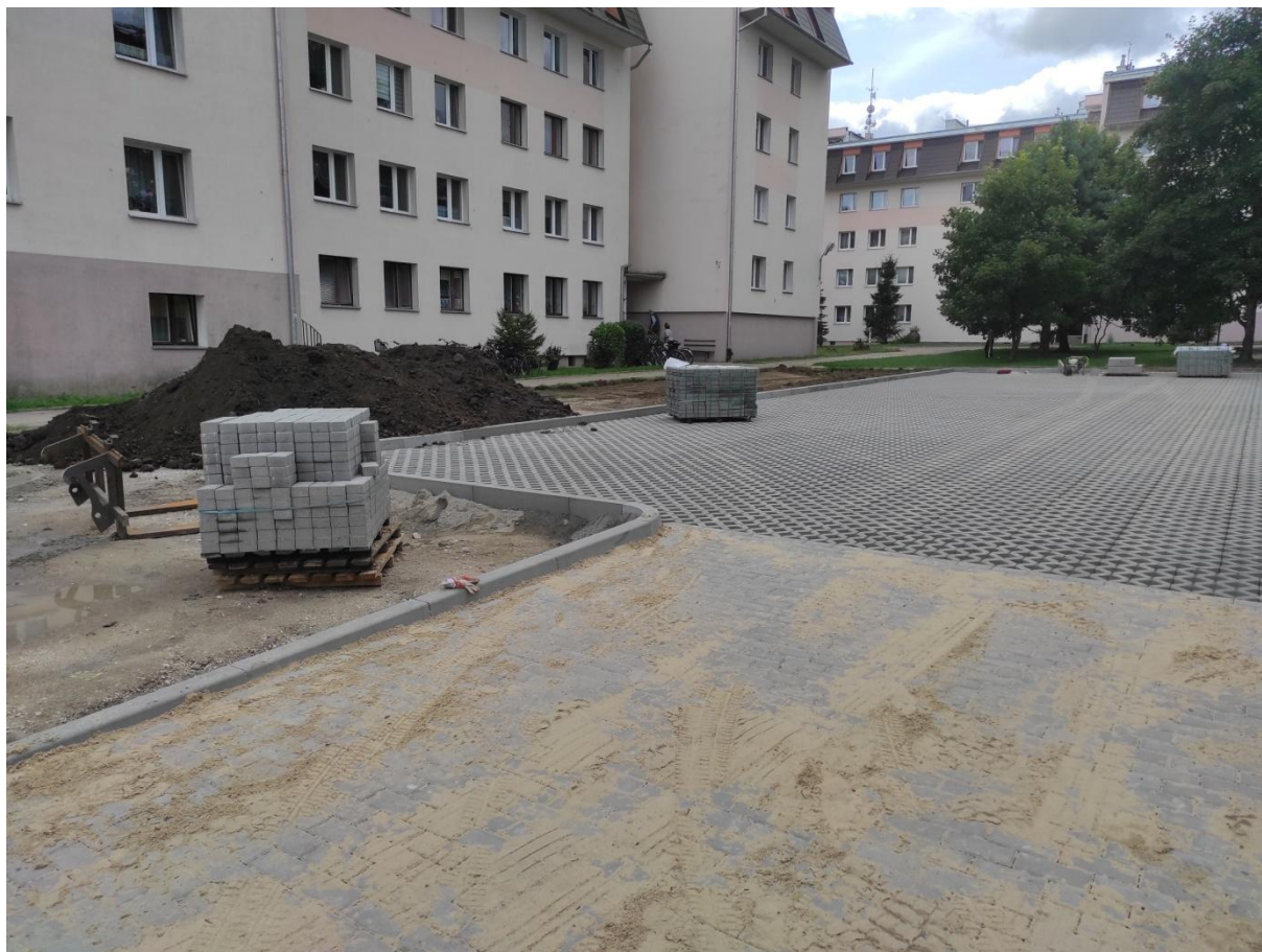
Parking w trakcie realizacji
