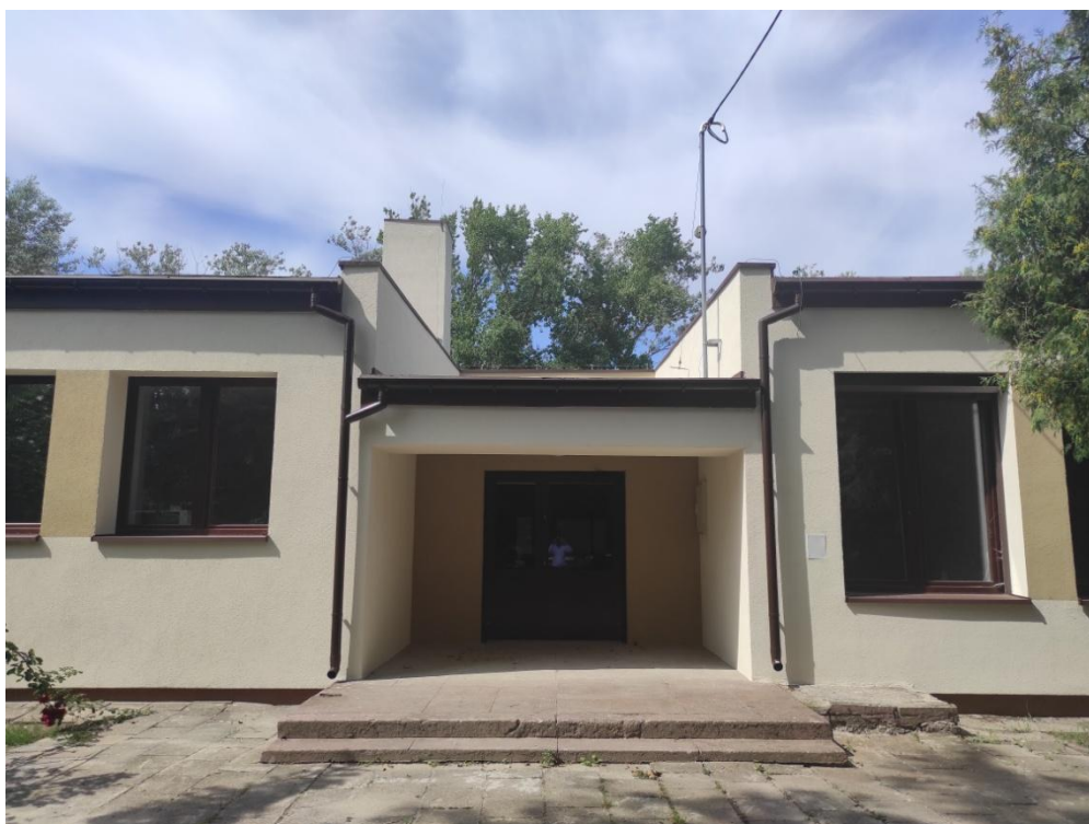
Wejście główne do budynku w Siemnowku po realizacji
