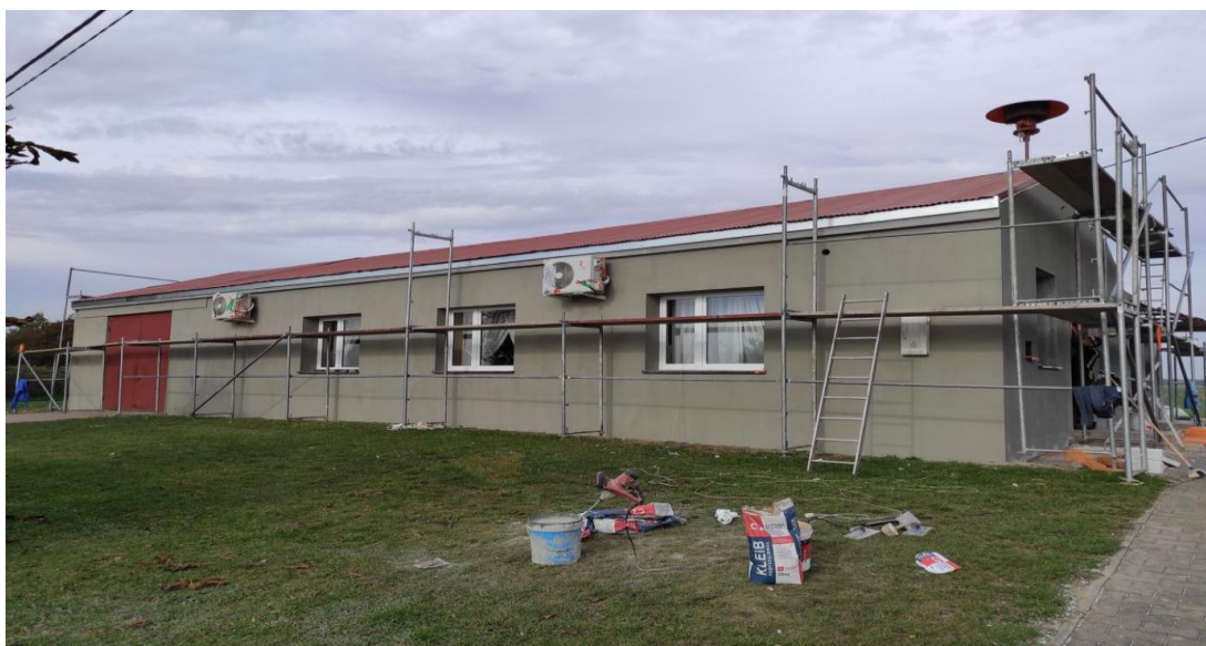
Budynek remizy OSP w Sarnowie w trakcie prac
