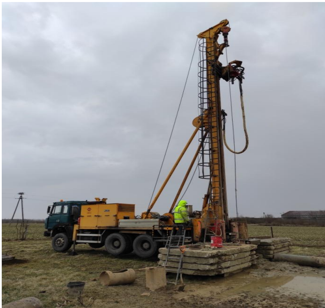
Budowa studni nr 4
