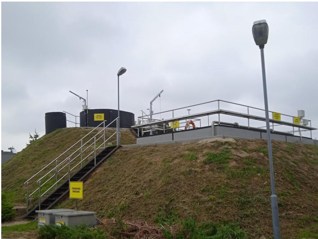
Oczyszczalnia ścieków w Żydowie – widok ogólny
