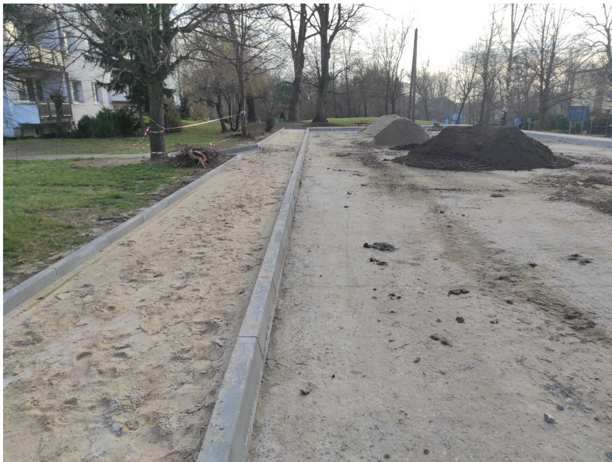
Parking w trakcie przebudowy
