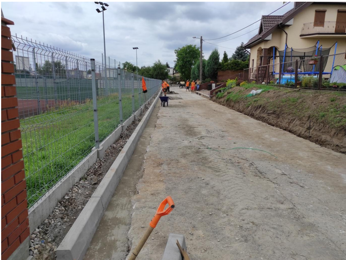
Przebudowa ul. Mierosławskiego
