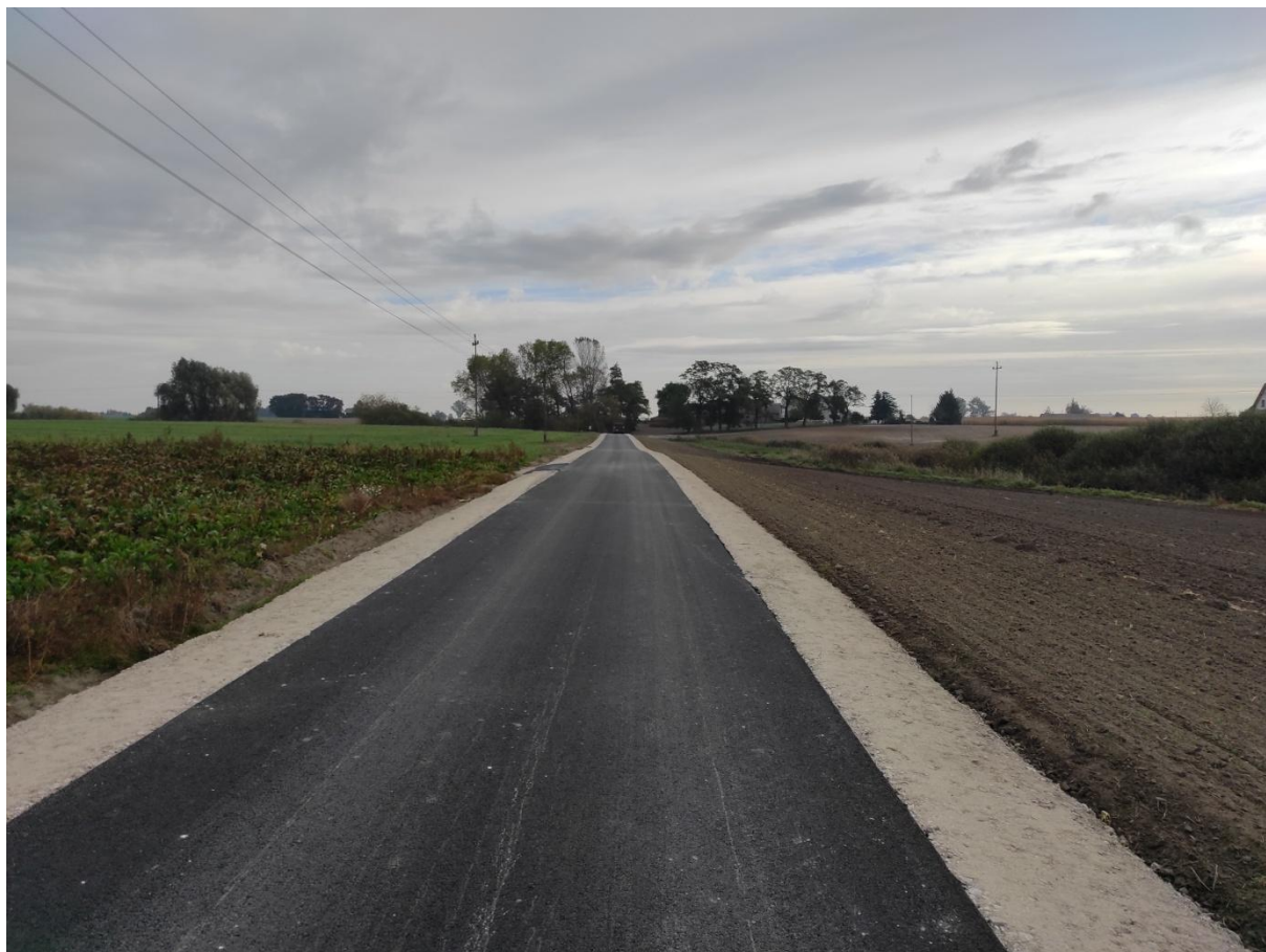
Droga gminna po realizacji
