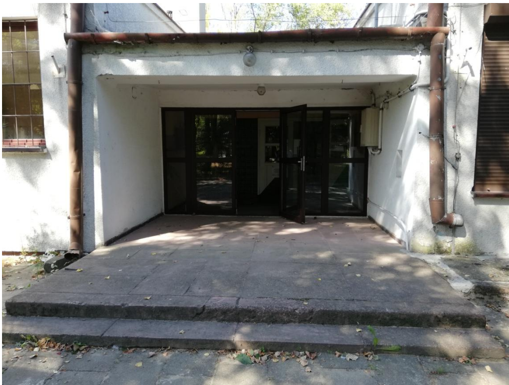
Wejście główne do budynku w Siemnowku przed realizacją
